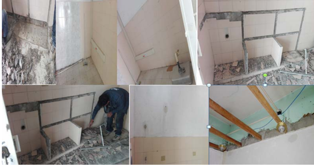
Fuente: Suministrada por operarios de mantenimiento
