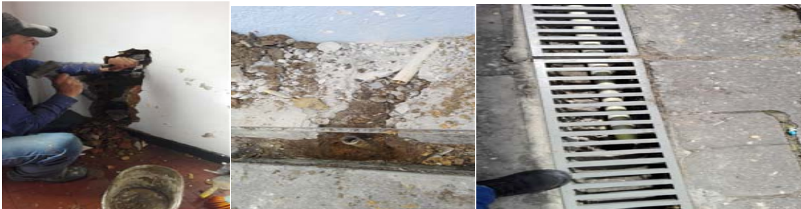
Mantenimiento correctivo consulta externa
