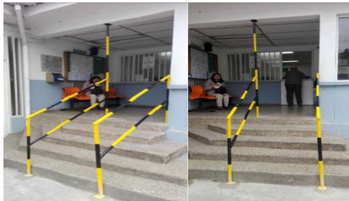
Instalación de barandas Consulta Externa en UFZ
